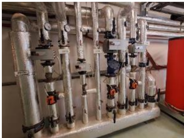
Obrázek 15 Kombinovaný rozdělovač a sběrač topné vody – budova polikliniky (Objekt č. 3-5)
