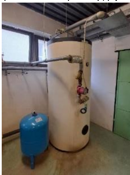
Obrázek 14 Zásobník na teplou vodu 1 000 litrů – budova polikliniky (Objekt č. 3-5)
