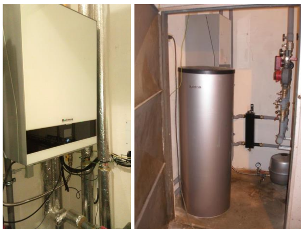
Obrázek 27 Kotel Buderus 48 kW, zásobníkový ohřívač teplé vody– objekt garáží (Objekt č. 17)
