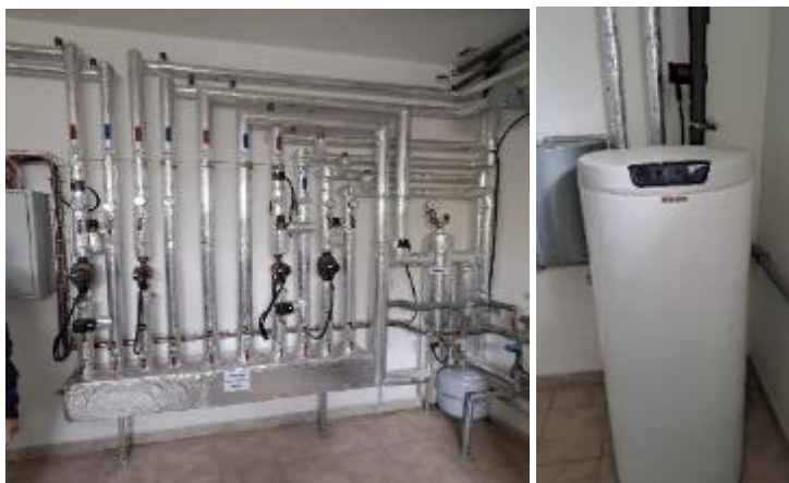
Obrázek 17 R/S topné vody, zásobníkový ohřívač teplé vody – objekt lékárny a plicní ambulance (Objekt č. 6)
