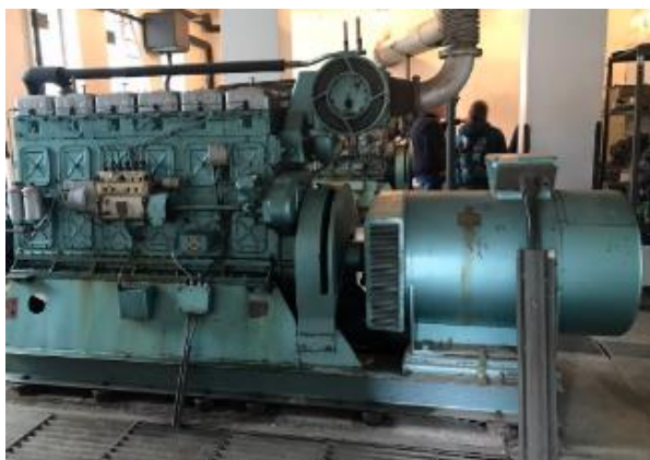
Obrázek 40 Záložní zdroj pro původní objekty nemocnice
