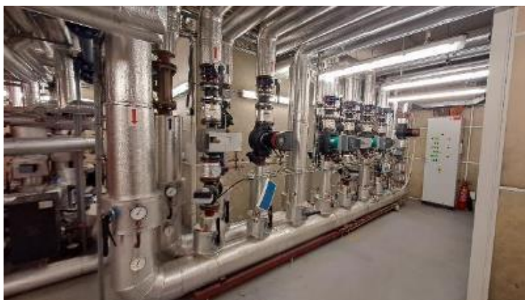
Obrázek 11 Rozdělovač a sběrač topné vody – objekt Monoblok (Objekt č. 1-2)
