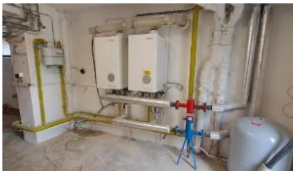
Obrázek 20 Kaskáda závěsných kotlů Brötje 2 x 49,5 kW – objekt nukleární medicíny (Objekt č. 10)
