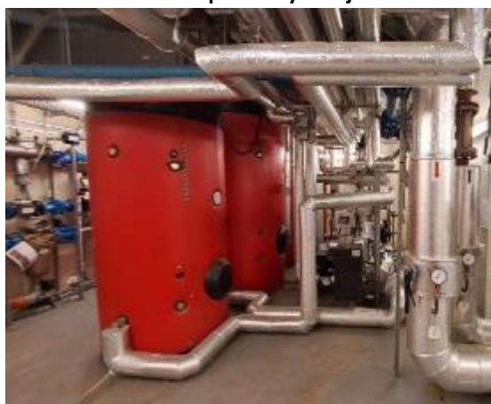
Obrázek 12 Výměníky a zásobníky pro přípravu teplé vody – objekt Monoblok (Objekt č. 1-2)
