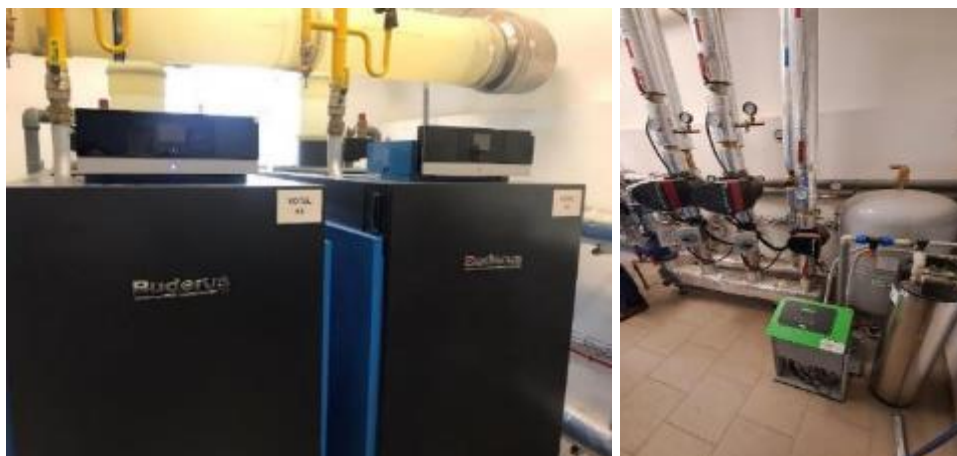
Obrázek 26 Stacionární kotle Buderus 2 x 200 kW (vlevo) a rozdělovač a sběrač topné vody s expanzním automatem s úpravnou vody (Objekt č. 16)
