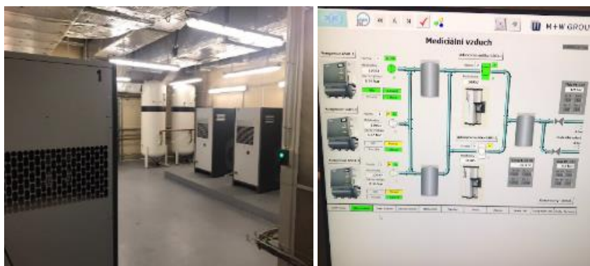
Obrázek 56 Technologie a řízení kompresorové stanice
