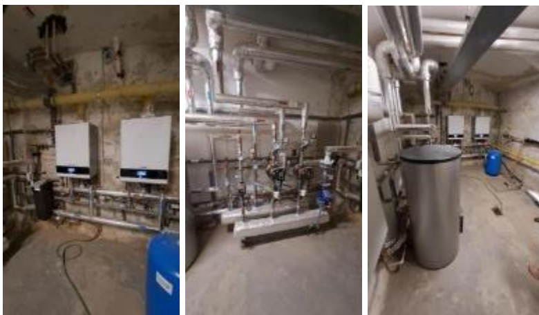
Obrázek 23 Závěsné kotle Buderus 2 x 48 kW, R/S topné vody a zásobníkový ohřívač – objekt patologie (Objekt č. 13) Zázemí patologie (Objekt č. 14)
