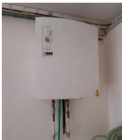
Obrázek 29 Elektrokotel – objekt skladu medicínálních plynů (Objekt č. 21)
