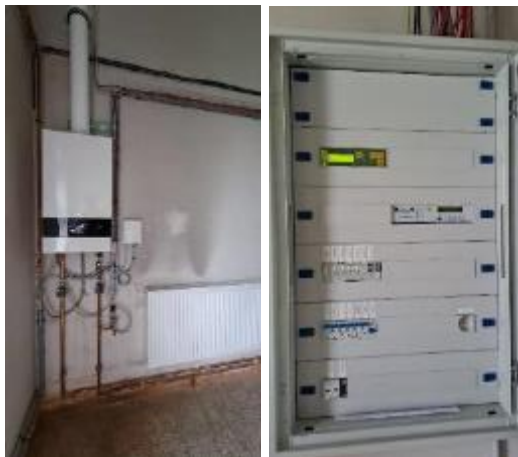
Obrázek 30 Kotel Buderus 24 kW a rozvaděč měření a regulace – objekt záložních zdrojů (Objekt č. 22)
