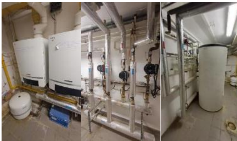
Obrázek 25 Závěsné kotle Buderus 2 x 45 kW, R/S topné vody a zásobník teplé vody – objekt soc. lůžek (Objekt č. 15)
