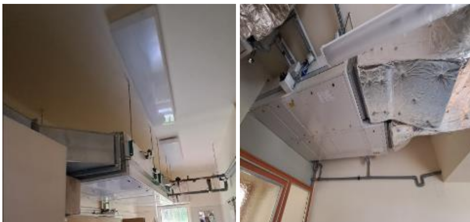
Obrázek 46 Umístění VZT jednotky pro větrání přípravy radiofarmak
