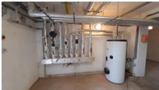
Obrázek 21 R/S topné vody, zásobníkový ohřivač teplé vody – objekt nukleární medicíny (Objekt č. 10)
