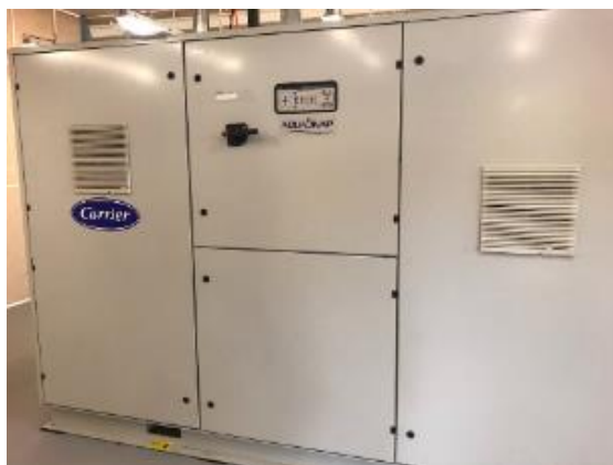
Obrázek 52 Zdroj chladu pro objekt č. 2 (umístěn 6NP)
