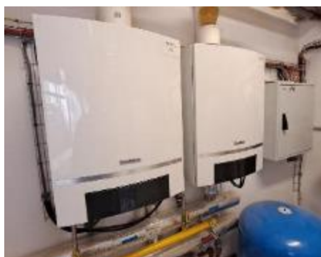
Obrázek 18 Kaskáda závěsných kotlů Buderus 2 x 45 kW – objekt OKBH (Objekt č. 8)
