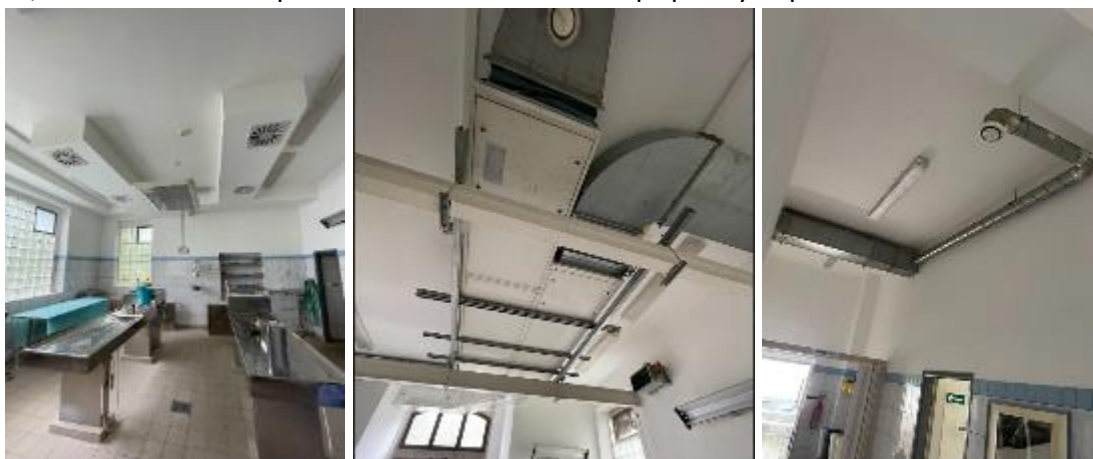
Obrázek 47 VZT pro Objekt č. 13 Patologicko-anatomické oddělení, vlevo distribuce vzduchu pitevny, uprostřed VZT jednotka s rekuperací, vpravo distribuce vzduchu chodby
