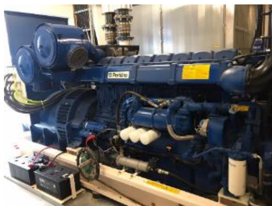
Obrázek 41 Záložní zdroj el. energie – dieselařegát objekt č. 23
