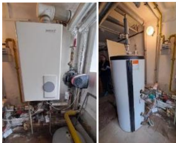
Obrázek 22 Závěsný kotel Brötje 49,5 kW a zásobníkový ohřivač vody – objekt dialýzy (Objekt č. 11)
