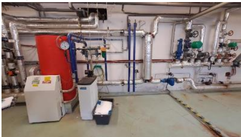
Obrázek 13 Předávací stanice pára-voda– budova polikliniky (spojovací chodba mezi Objekty č. 3-5)
