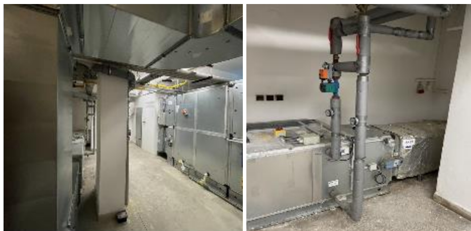
Obrázek 49 Vzduchotechnika pro stravovací provoz (strojovna v 1PP)
