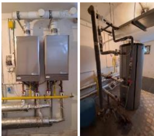
Obrázek 28 Kaskáda kotlů Therm 2 x 45 kW a zásobníkový ohřívač teplé vody – objekt ubytovny (Objekt č. 18)
