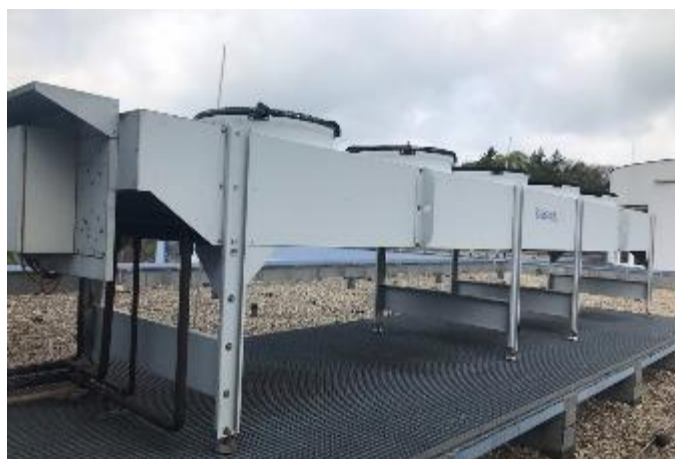
Obrázek 51 Kondenzační jednotka zdroje chladu na střeše budovy
