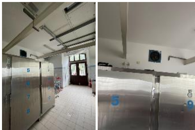
Obrázek 48 Ventilátor pro odvod tepelné zátěže od chladících boxů
