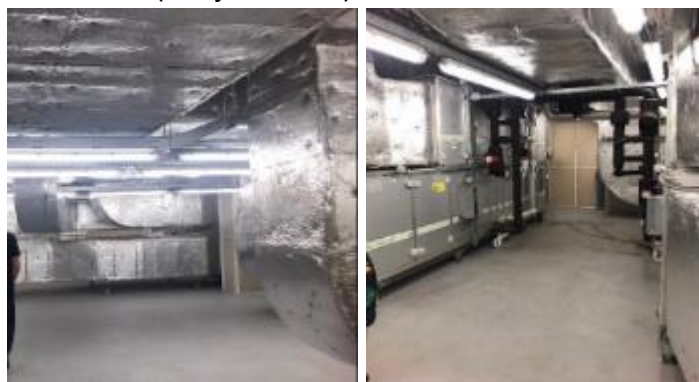
Obrázek 43 Strojovna vzduchotechniky v 1PP, objekt č. 1 Monoblok - Komplement
