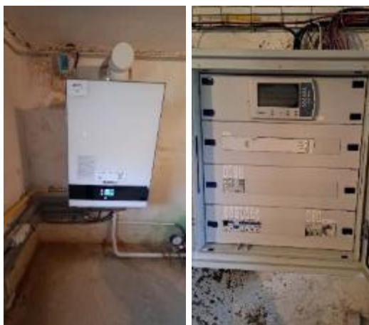
Obrázek 24 Závěsný kotel Buderus 48 kW a rozvaděč měření a regulace – objekt zázemí patologie (Objekt č. 14)
