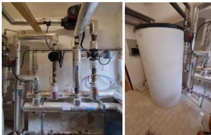
Obrázek 19 R/S topné vody, zásobníkový ohřivač teplé vody – objekt OKBH (Objekt č. 8)
