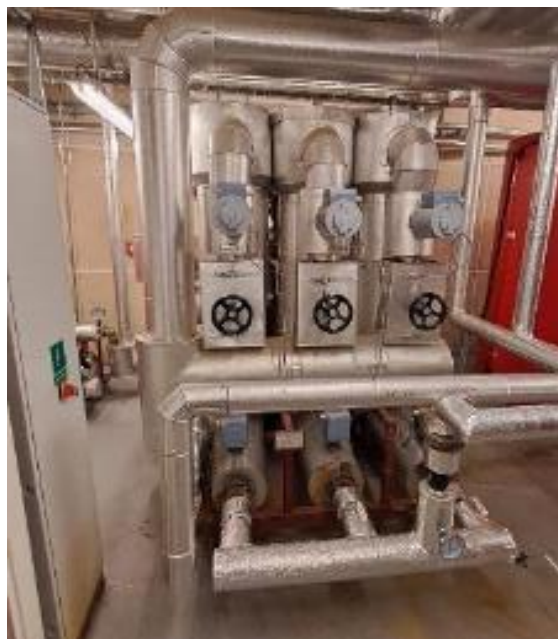
Obrázek 10 Sestava výměníků pára-voda 3x900 kW objekt Monoblok (Objekt č. 1-2)
